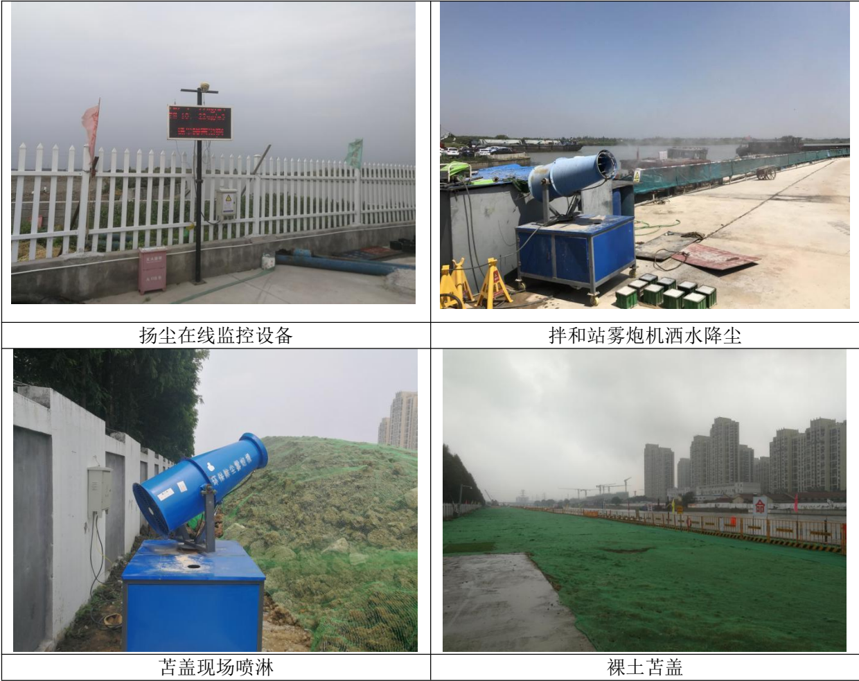
图 7.1-1 施工期大气污染防治措施照片
